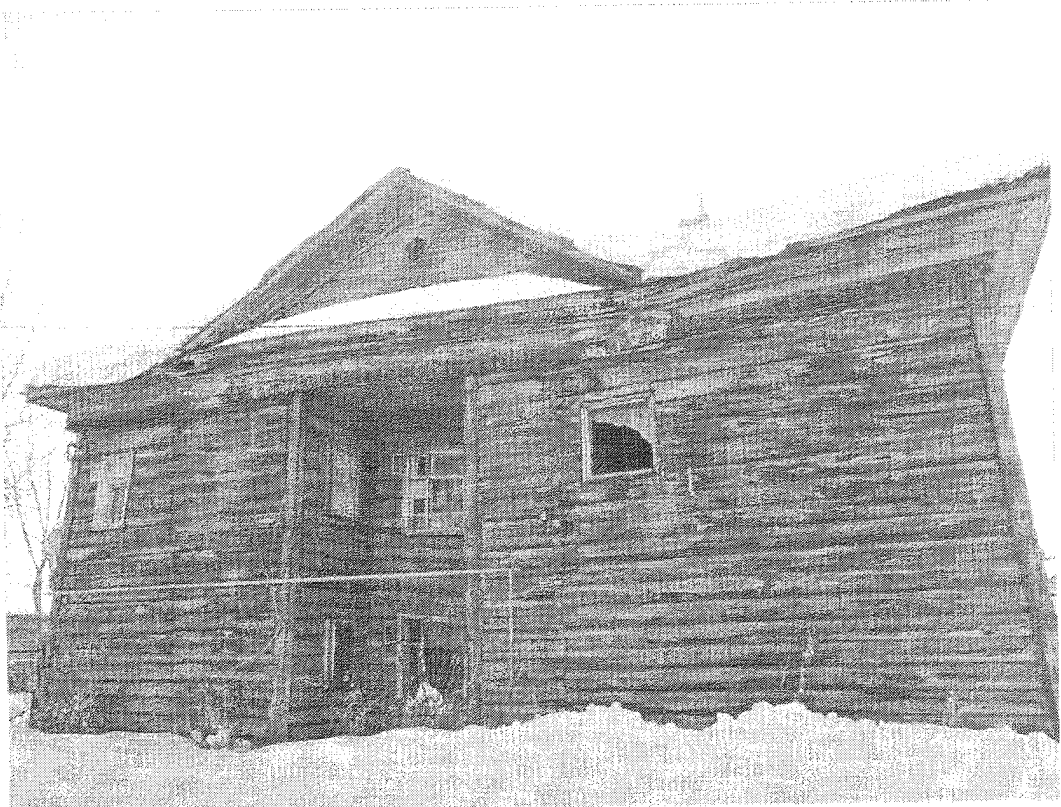
Фото 3 от 03.03.2025. Северо-восточный фасад.
