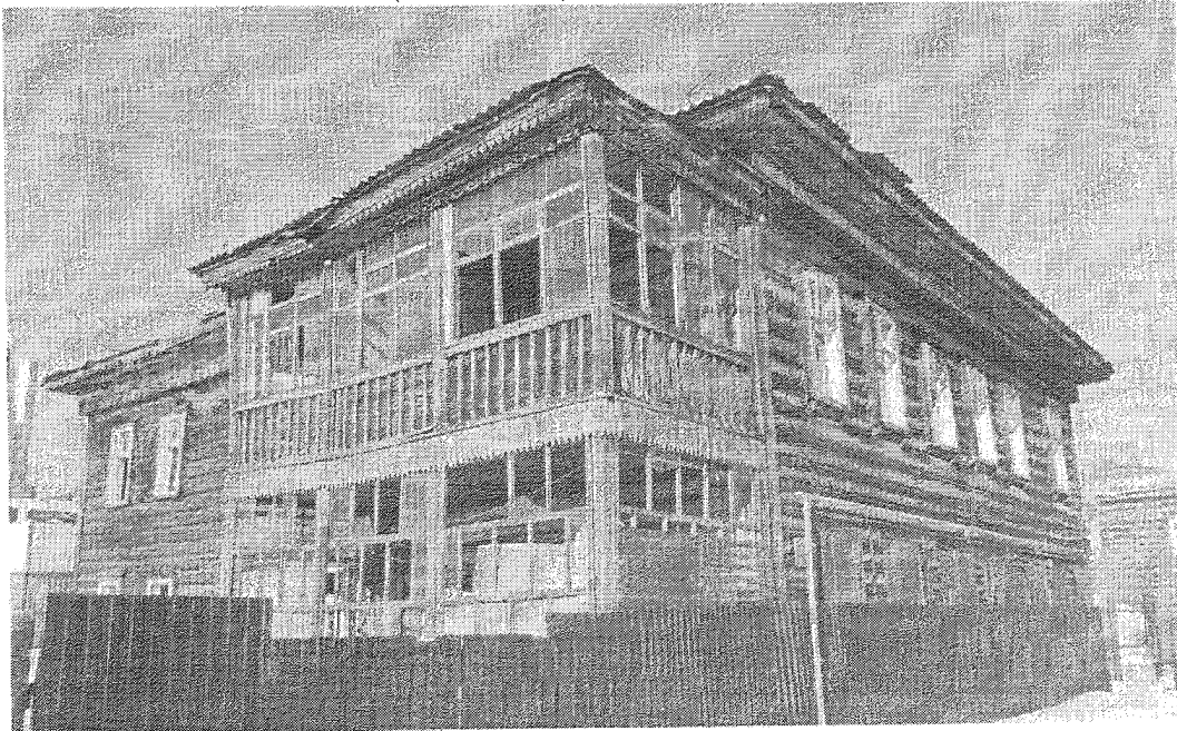
Фото 1 от 03.03.2025. Угол юго-восточного и юго-западного фасадов.
